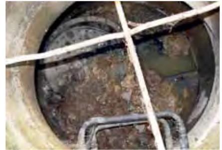
*Wie dringend notwendig die Kanalreinigung bereits gewesen ist, zeigt dieses Bild. Der Schotterfangkorb bei einem Schacht ist gebrochen und führte bereits zu einer Verstopfung des Kanals. In einigen Tagen wäre sicherlich bereits bei den betroffenen Häusern das WC übergelaufen.*
