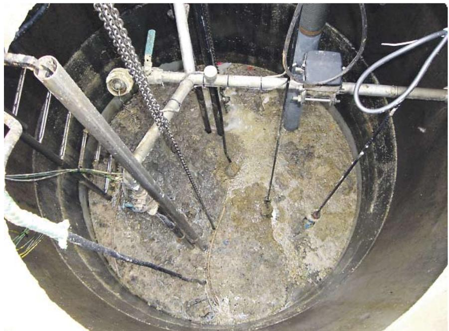
*So sieht es in einer Pumpstation aus, wenn zuviel Altspesiefette über den Kanal entsorgt werden. Nach einiger Zeit funktionieren die Pumpen nicht mehr und das Pumpwerk muss mit großen Kosten gereinigt werden.*
