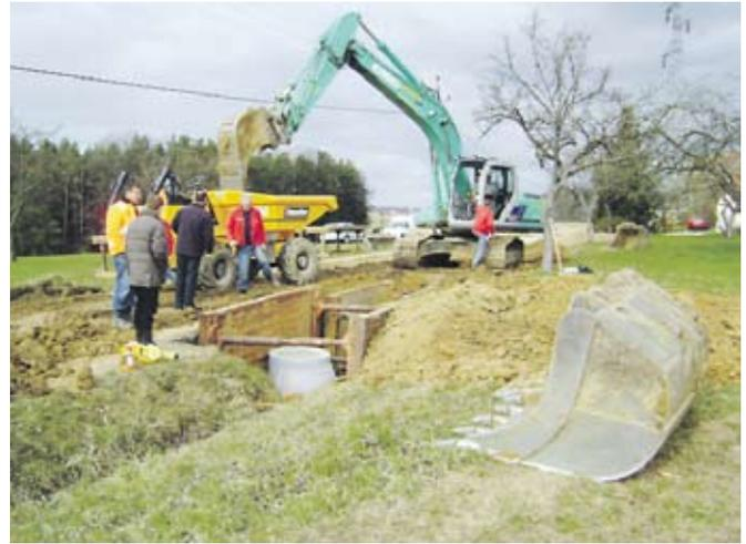
werke bei der Teichschenke und der Festhalle saniert. Beide Pumpwerke waren wegen Korrosion der Armaturen und Rissen im PVC-Pumpschacht unbedingt zu erneuern. Im kommenden Jahr sind noch die Asphaltierungs- und kleinere Rest-
